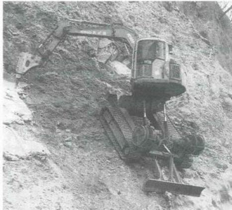
法面掘削を行うロッククライミングマシン
